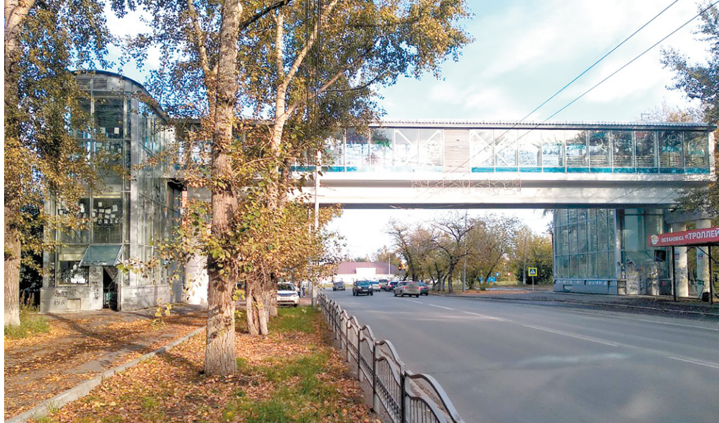
Надземный пешеходный переход в конце проспекта Фрунзе
