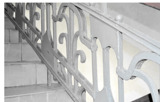
Фрагмент ограждения лестницы. Фото В.Г. Залесова
